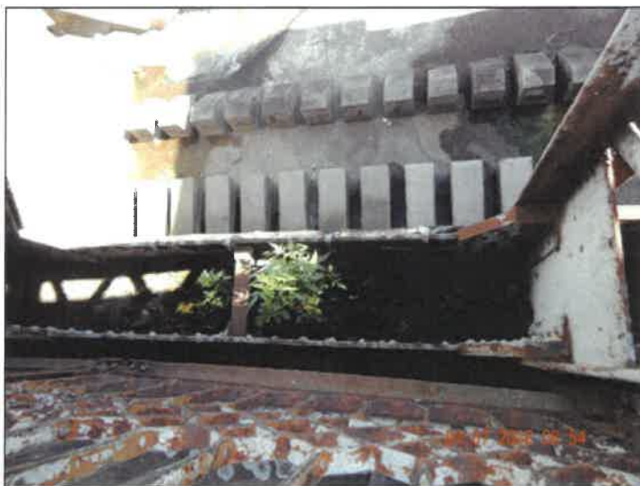
NK - pole 3, zanesený truhlík dolního nosníku.
