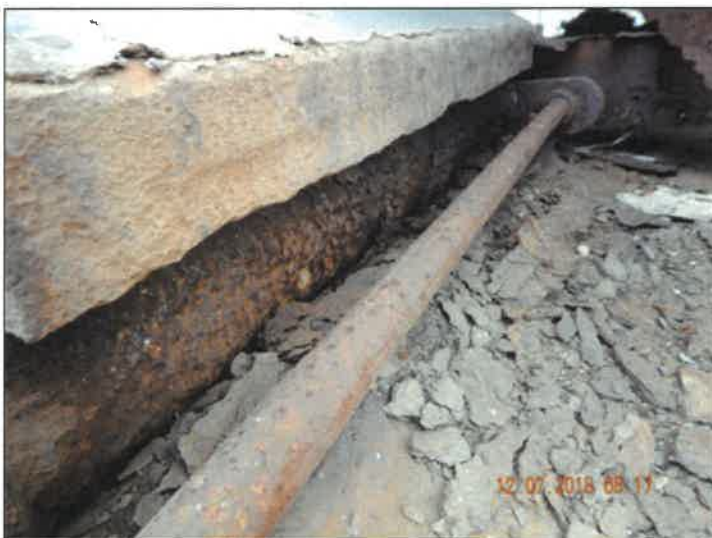
Detail koroze ložiskového válce pilíře P2 - délková koroze.
