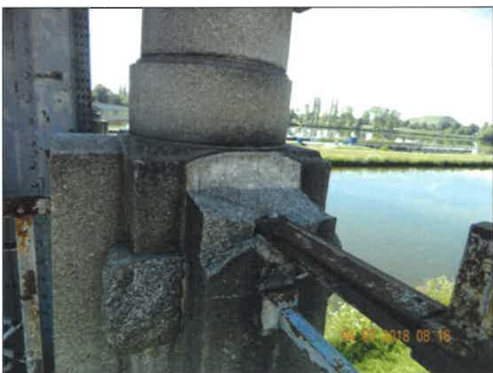
Odštípnutý kamenný sloupek zábradlí na předpolí OP1.
