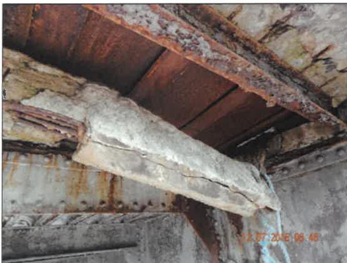
Utržený betonový trám v poli 2 - havarijní stav (hrozí pád pod most).
