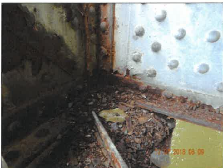
NK - pole 1, nánosy nečistot u styčnicku hlavního nosníku, silná koroze.
