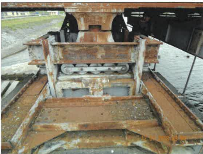
Pohled na ložisko na pilíři P3.
