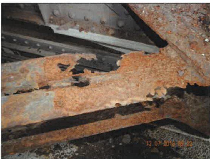
NK - pole 3, velmi silná koroze vodorovného ztužení pole 3.
