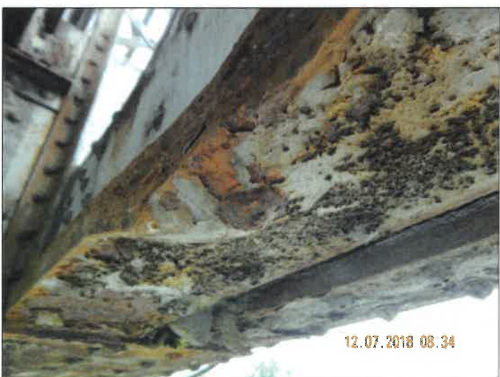
NK - pole 2, deformovaná pásnice v 1/2 rozpětí pole 2 na levé straně mostu.
