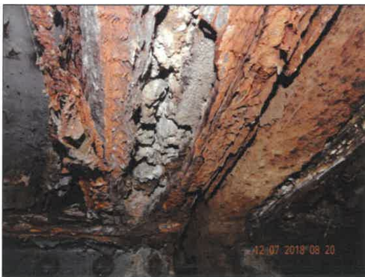
Detail silné koroze ocelových profilů u dilatační spáry na pilíři P2.
