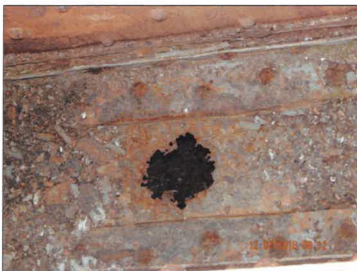
NK - pole 3, silná koroze v místě odvodňovacího otvoru dolního nosníku.
