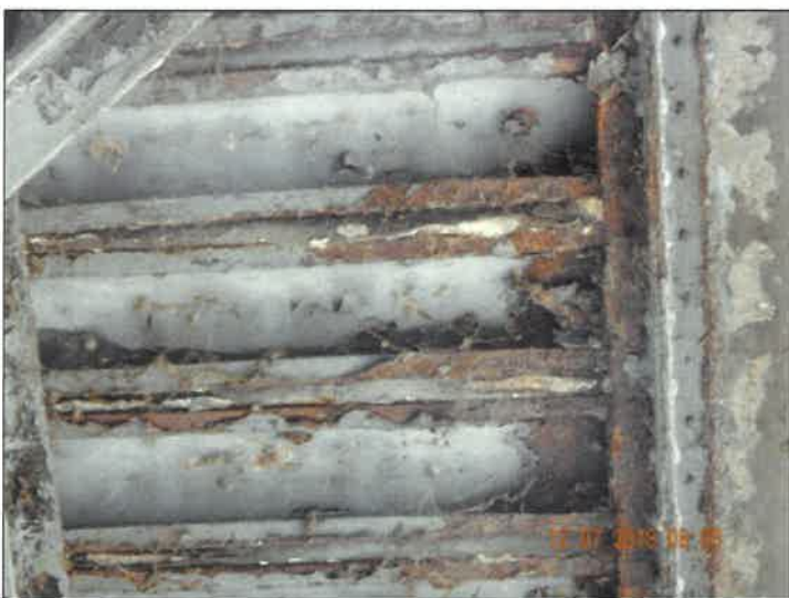
Silná koroze podlažnic Zorés v krajní části v místě uložení na podélník.
