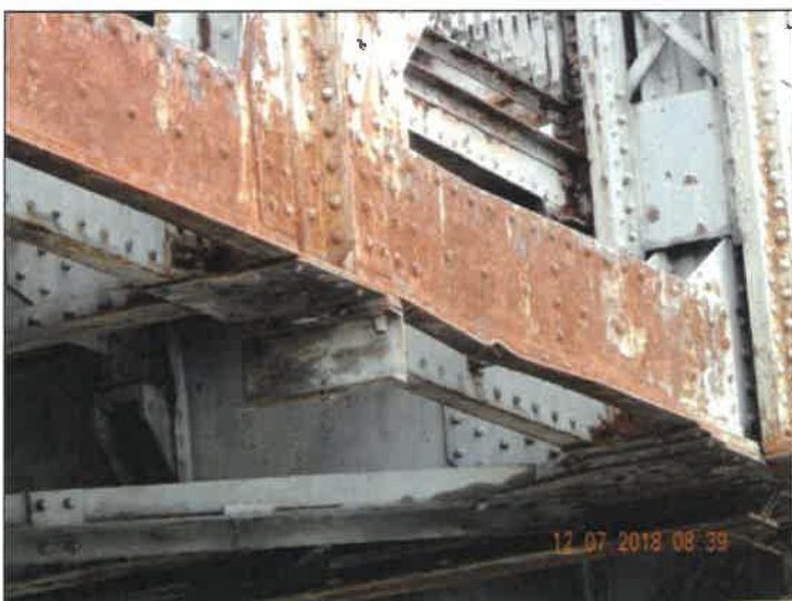
NK - pole 2, deformovaný nosník po nárazu na pravé straně mostu v poli 2, cca 2/3 rozpětí pole.
