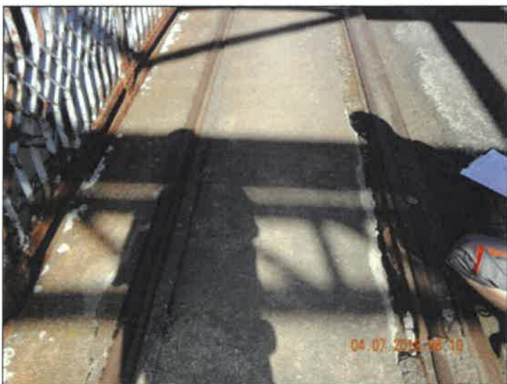
Rozpad betonového chodníku podél koleje vlečky.
