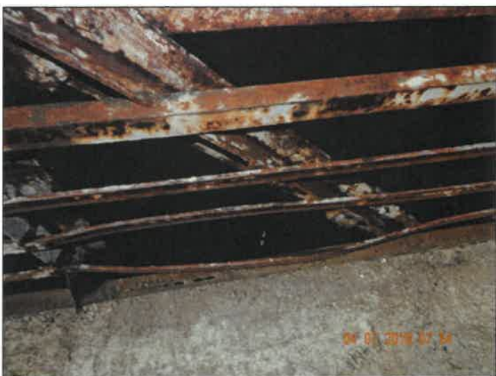
Deformovaná zábradelní výplň po nárazu.
