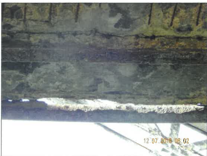
Prokorodovaný a vyhnutý krajní nosník pod chodníkem.
