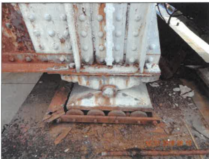
Pohled na ložisko na pilíři P2.
