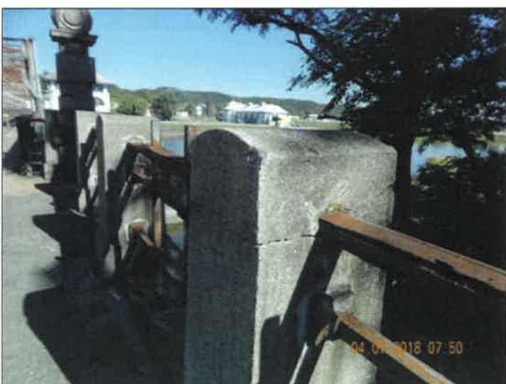
Prasklý kamenný sloupek zábradlí v poli 5.
