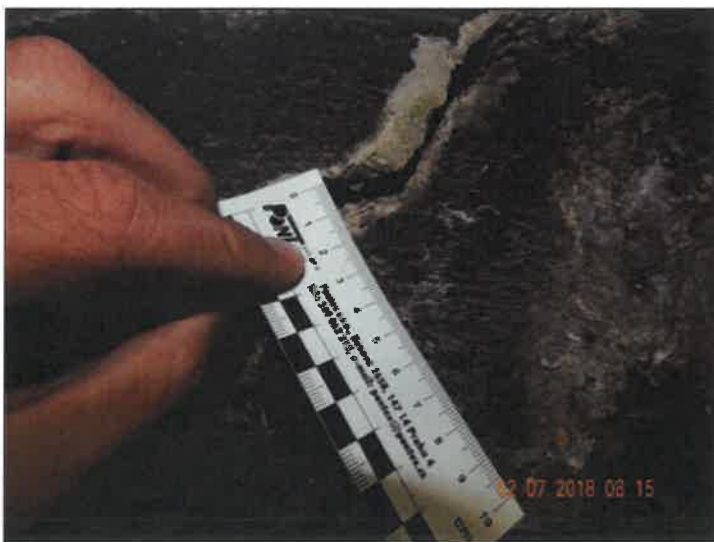
Detail trhliny šířky až 10 mm napojení chodníku nad příčným.
