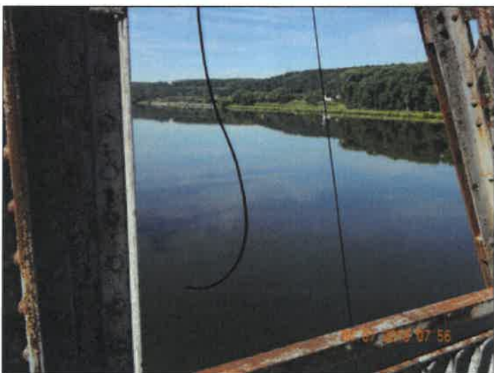
Volně vysící kabelové vedení v poli 4.
