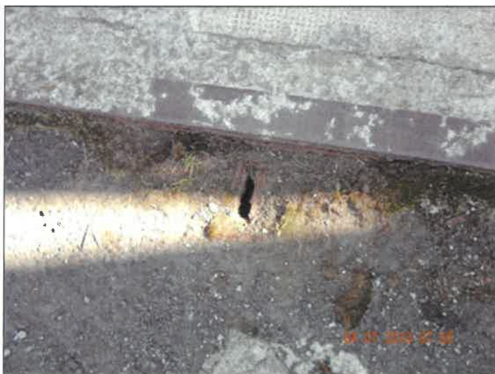
Zanesené odvodňovací otvor na kraji vozovky.
