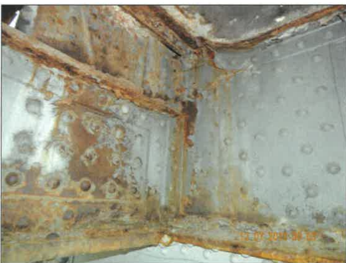
NK - pole 3, detail napojení příčnicku na hlavní nosník, silná koroze.
