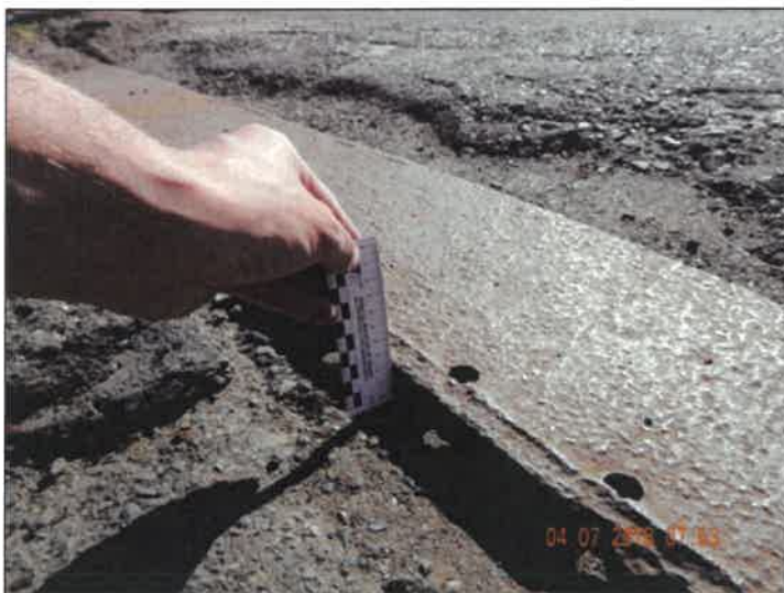
Vyhnutý plech mostního závěru nad opěrou OP6.
