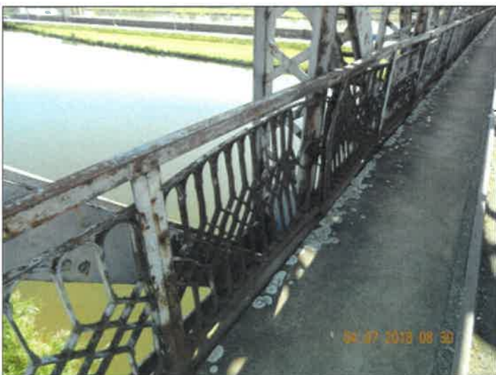
Deformovaná zábradelní výplň po nárazu.
