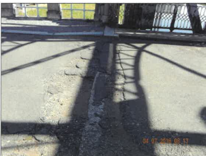
Rozpad vozovky okolo mostního závěru nad OP1.
