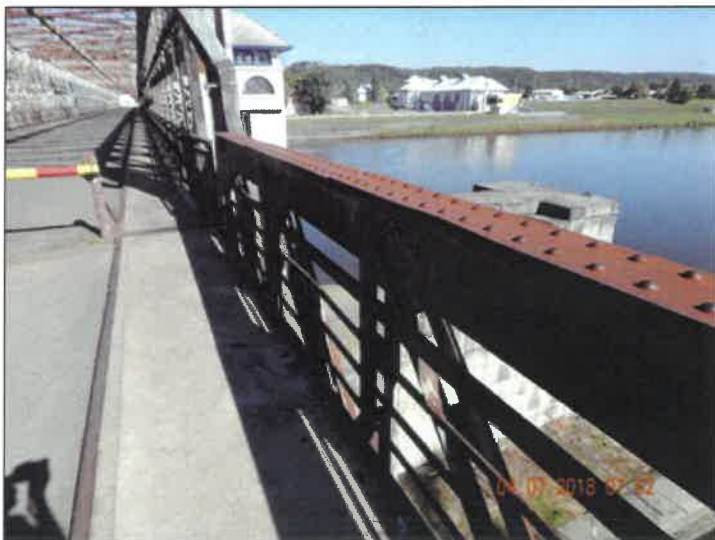
NK - pole 5, deformace horní pásnice hlavního nosníku v poli 5 vlivem rozpinání koroze.
