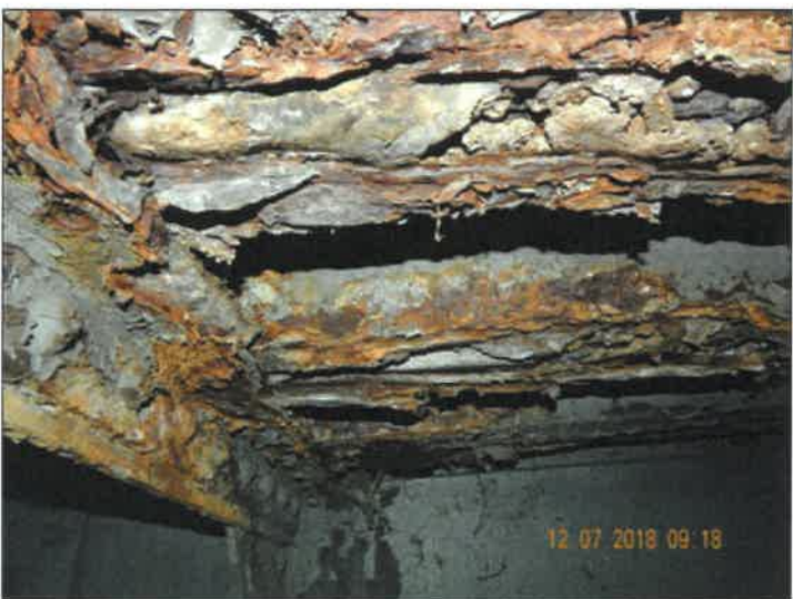
Silná koroze ocelové mostovky ZORES, protřzená izolace.
