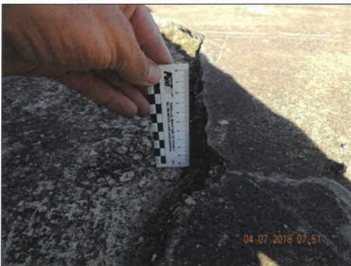
Detail rozpadu horní vrstvy chodníku do hl. 50 mm.
