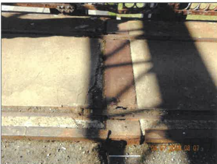
Mostní závěr na chodníku, rozpad betonu, koroze plechů.
