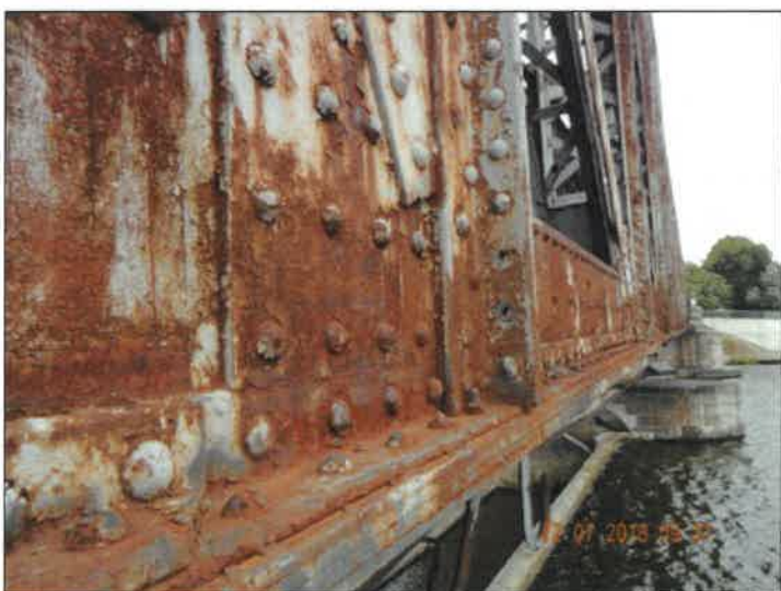
NK - pole 4, silná koroze pravého (návodního) nosníku, lokálně chybí nýty.
