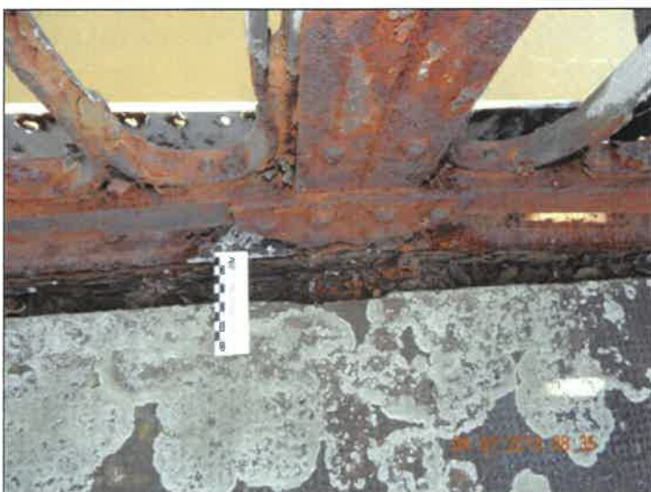
Detail deformovaných zábradelních výplňí po nárazu.
