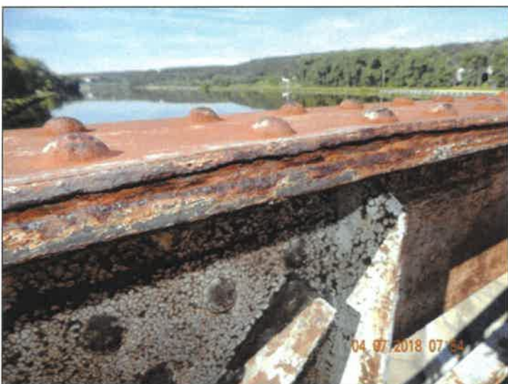
NK - pole 5, deformace horní pásnice hlavního nosníku v poli 5 vlivem rozpinání koroze - detail deformace horní pásnice.
