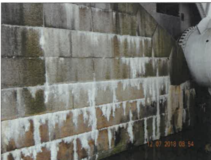
Pilíř P3 ve spodní části průsaky s výkvěty.
