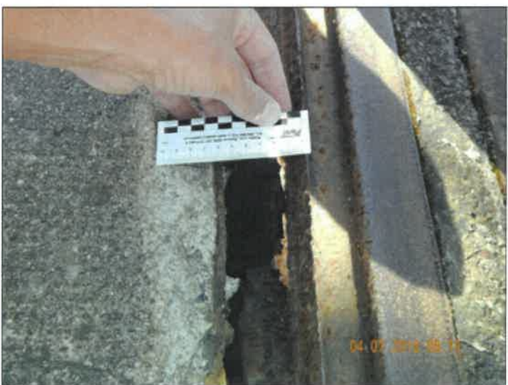
Detail rozpadu betonového chodníku podél koleje vlečky.
