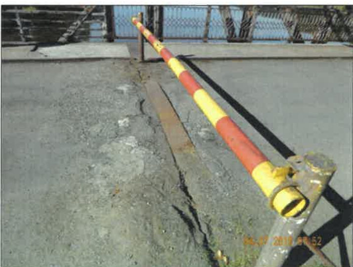
Rozpad vozovky okolo mostního závěru nad OP6.
