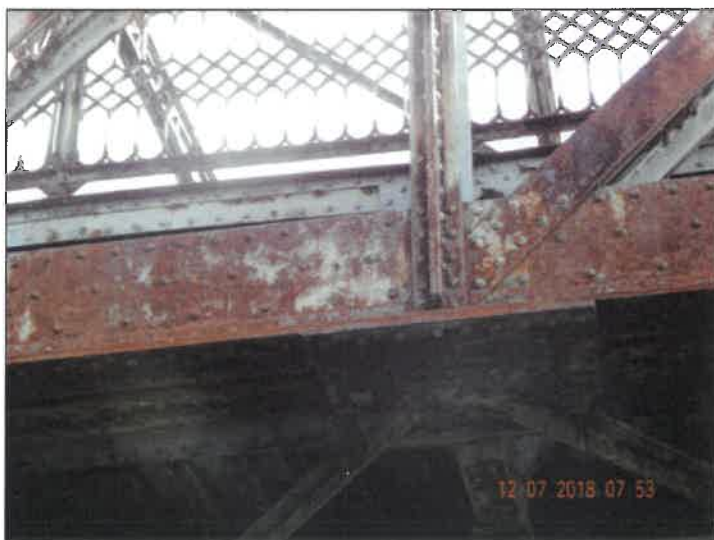
NK - pole 1, silná koroze levého hlavního nosníku.
