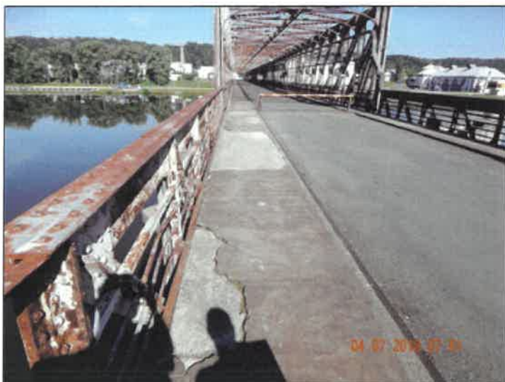
Rozpad horní vrstvy chodníku do hl. 50 mm.
