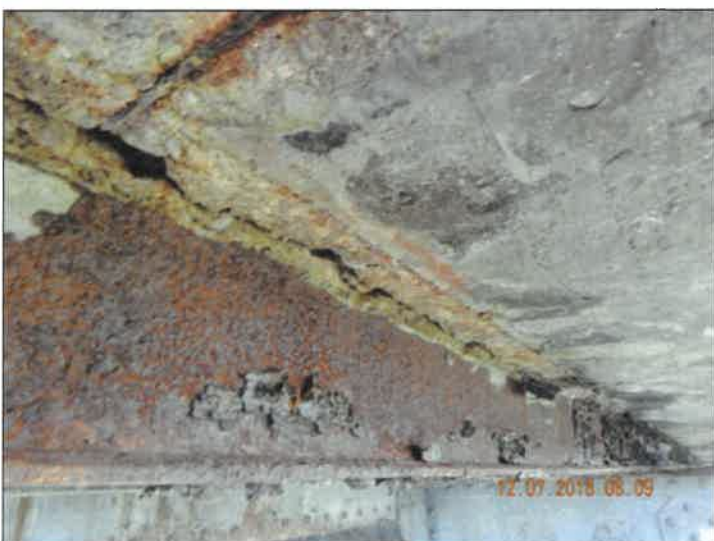
Prokorodovaný podélný nosník pod pravým (návodním) chodníkem.
