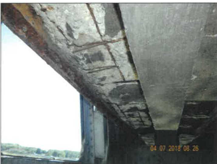
Pohled na spodní líc chodníku na levé (povodní) straně mostu, separace krycí vrstvy, koroze výztuže (pole 1).
