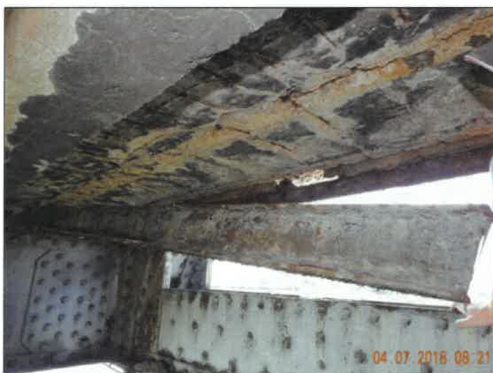
Překorodovaný podélník pod chodníkem v poli 1 na pravé straně mostu - havarijný stav (hrozí pád most).
