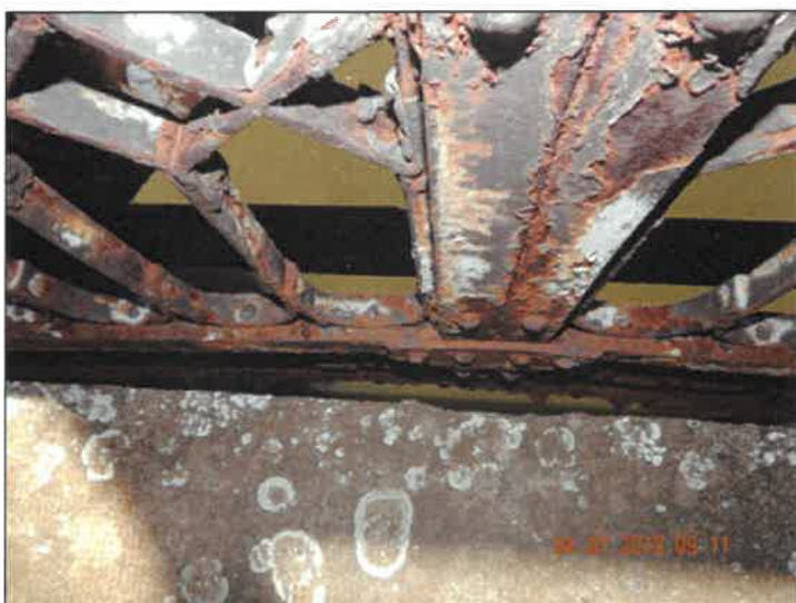
Deformované zábradelní panely na úrovni chodníku.
