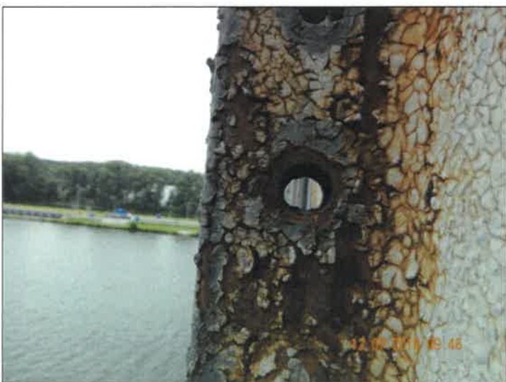
NK - pole 4, detail lokálně chybějícího nýtu.
