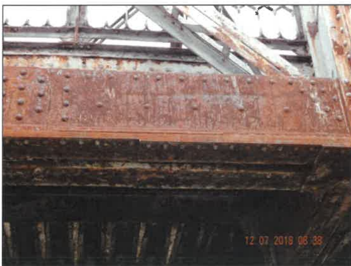
NK - pole 2, silná koroze levého hlavního nosníku.
