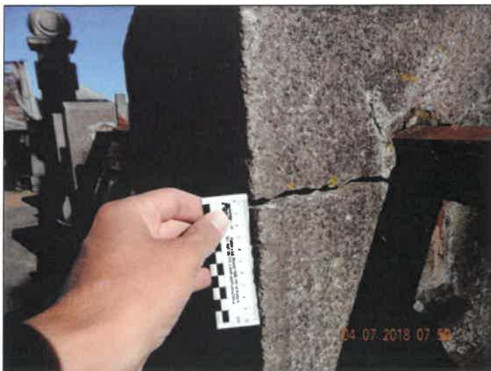
Detail trhliny v sloupku.
