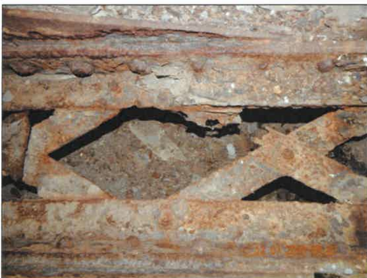
Silná koroze části ocelového ložiska na pilíři P3.
