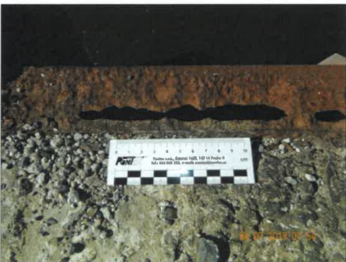
Prokorodovaný ocelový římsový profil.
