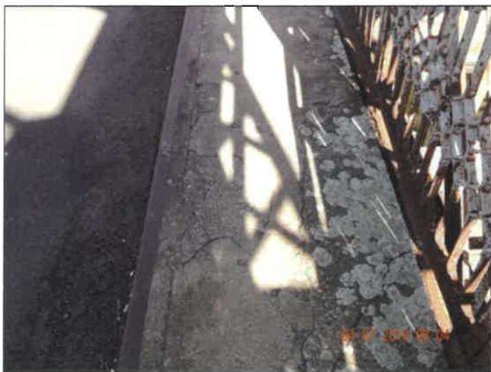
Sítě trhlín na horním povrchu chodníku.
