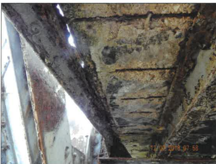
Rozpad pravého (návodního) chodníku, deformace krajního profilu, silná koroze, degradace betonu.
