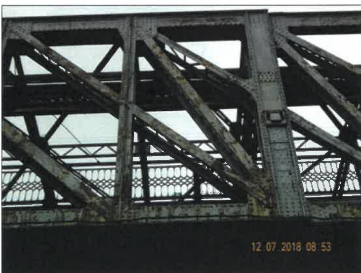
NK - pole 2, protikorozní ochrana levého hlavního nosníku je za koncem životnosti.
