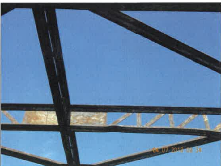
Deformovaný příčník horního ztužení.
