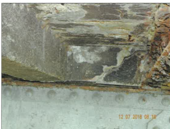
Šikmá trhлина v železobetonové desce chodníku nad příčným, deformace chodníku.
