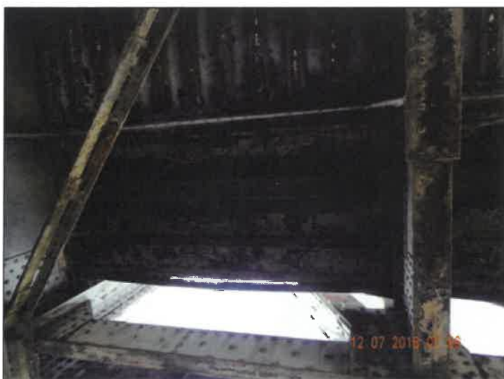
Pohled na spodní líc betonového chodníku na pravé (návodní) straně mostu, degradace betonu, separace krycí vrstvy, koroze výztuže. krajní deformovaný profil nepodpírá desku.
